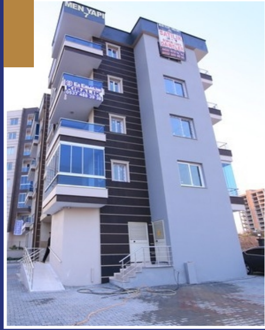
Mersin Yenişehirde Jimnastik Salonu yanı yapmış olduğumuz 9 daire 2+1 projemiz.
